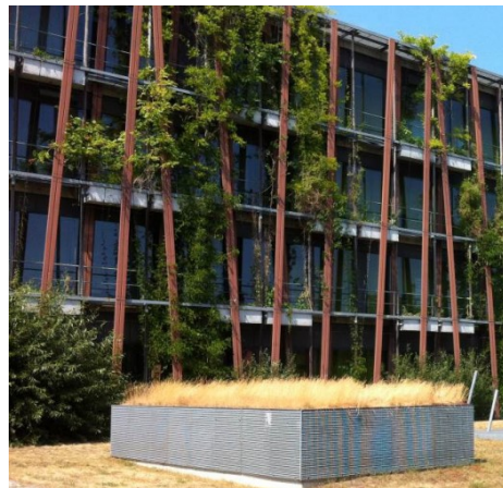
Esimerkki viherseinästä pysäköintitalossa (Kuva: Green Wall Project: Guadalupe Parking Garage)
